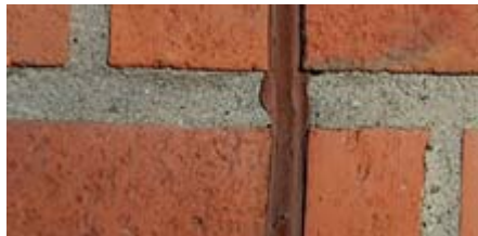
Den mjuka fogmassan (brun) innehåller PCB.
